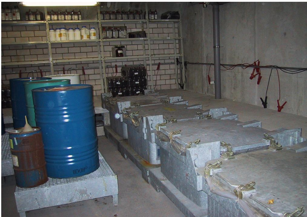
**Fig. 2:** Imagen de contenedores ASP cerrados para almacenar y transportar residuos.
