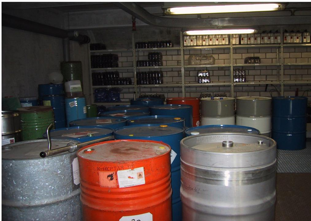
**Fig. 1:** Imagen de un almacén temporal. En primer término, los bidones de disolventes vacíos se encuentran separados de los residuos químicos almacenados (al fondo).
